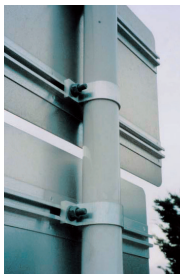
標識板 3のアップ写真
