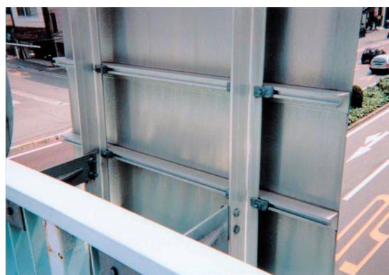
標識板 1 (既成材→アルミ板・高リブ・Tリブ・ ツメボルト使用)
